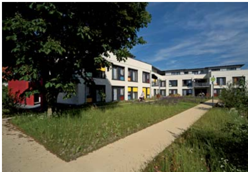
2010 Außenanlagen Haus der Diakonie, Lage, LP 1 - 9, 255.000 EURO
