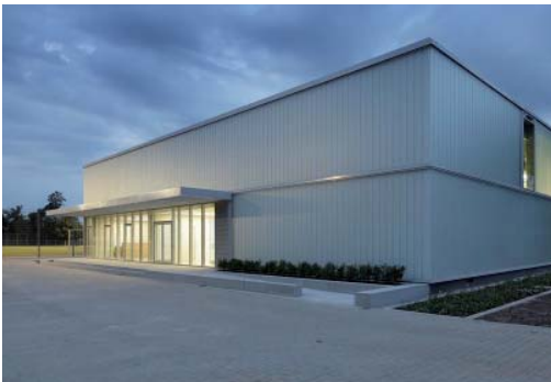
2010 Außenanlagen Sporthalle Ubbedissen, Bielefeld-Ubbedissen LP 1 - 9, 115.000 EURO
